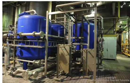
Het nieuwe gemeentehuis van Berkelland wordt verwarmd met heet water van de naastliggende zuivelfabriek van FrieslandCampina. © Annina Romita
